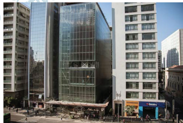
IMS Paulista em construção.
