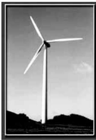
Uma das alternativas modernas para a geração de energia elétrica limpa e relativamente barata é a energia eólica. Para a avaliação preliminar da potência eólica de um gerador situado em um determinado local, é necessário calcular a energia cinética do vento que atravessa a área varrida pelas hélices desse gerador por unidade de tempo.
